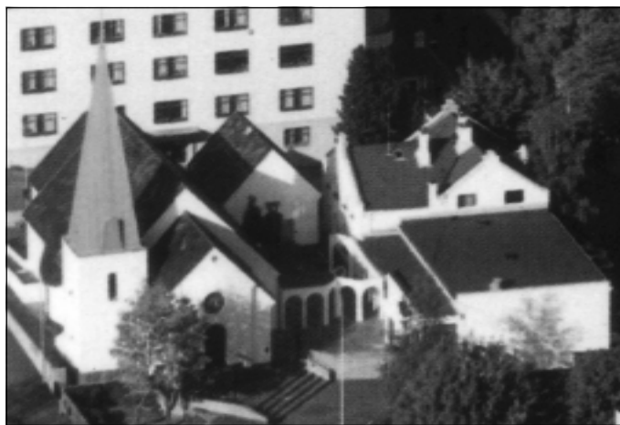
Budynki katolickiej parafii w Stavanger
